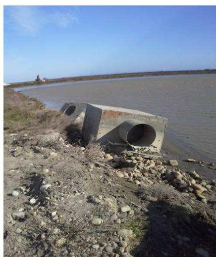
Mise en place et évacuation des dalots restants (photo : PNRC).
