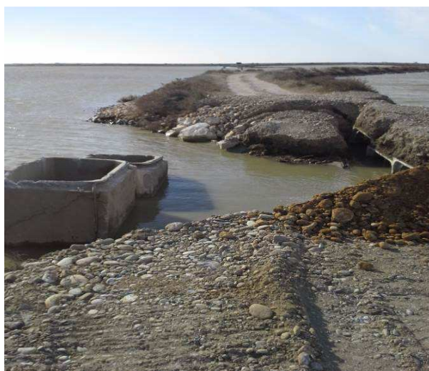
Mise en place et évacuation des dalots restants (photo : PNRC).
