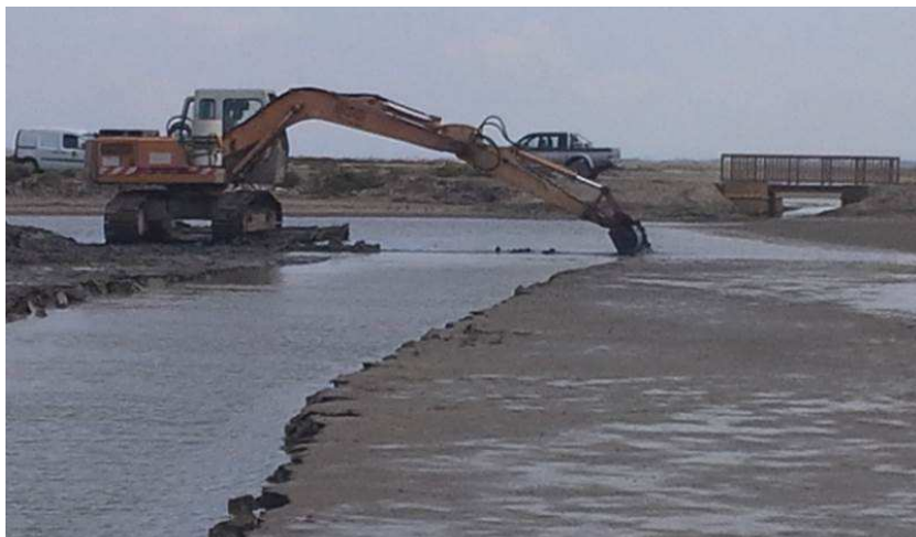
Curage du chenal dans l'étang de Beauduc avec la passerelle en fond (août 2015) (photo : PNRC).
