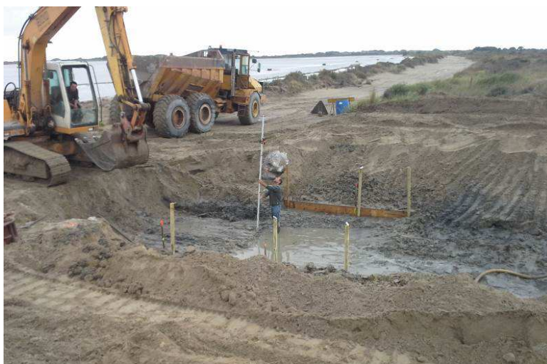
Terrassements d'implantation de l'ouvrage Galabert-Pourtour Rascaillan (Octobre 2015) (photo : PNRC).
