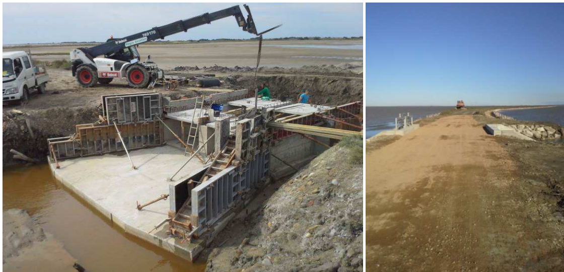
Coulage du reste du génie civil (septembre) et ouvrage terminé avec martelières et reprise de digue (novembre) (photos : Parc de Camargue).
