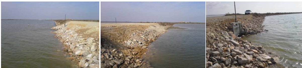
Ouvrage finalisé (à gauche côté Galabert, au centre côté Tampan, à droite vue sur la martelière).
