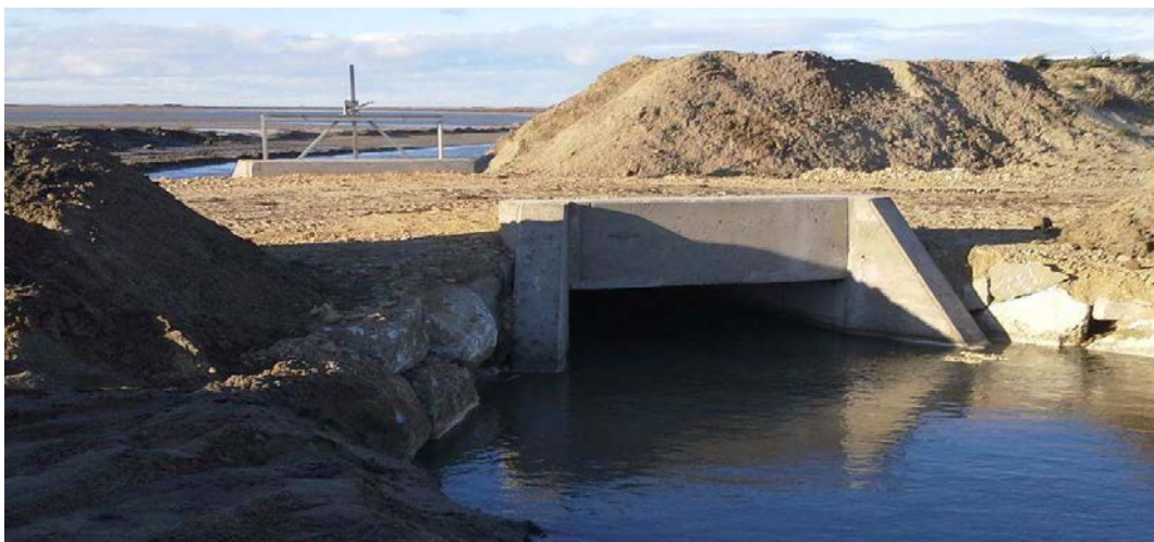
Le merlon le long de la piste des Toscans (en haut) et l'ouvrage de Pourtour 2 / Galabert 1 (en bas)
