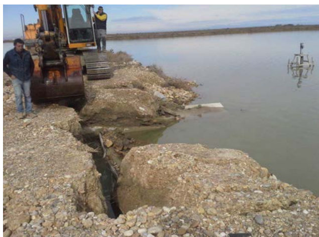
A gauche : Etat de l'ouvrage Tampan-Galabert (côté Galabert) avant démarrage des travaux de reprise de digue. A droite : Pose des bastaings, remblaiement en arrière et avec le tout venant et mise en place d'enrochements pour l'anti-batillage.
