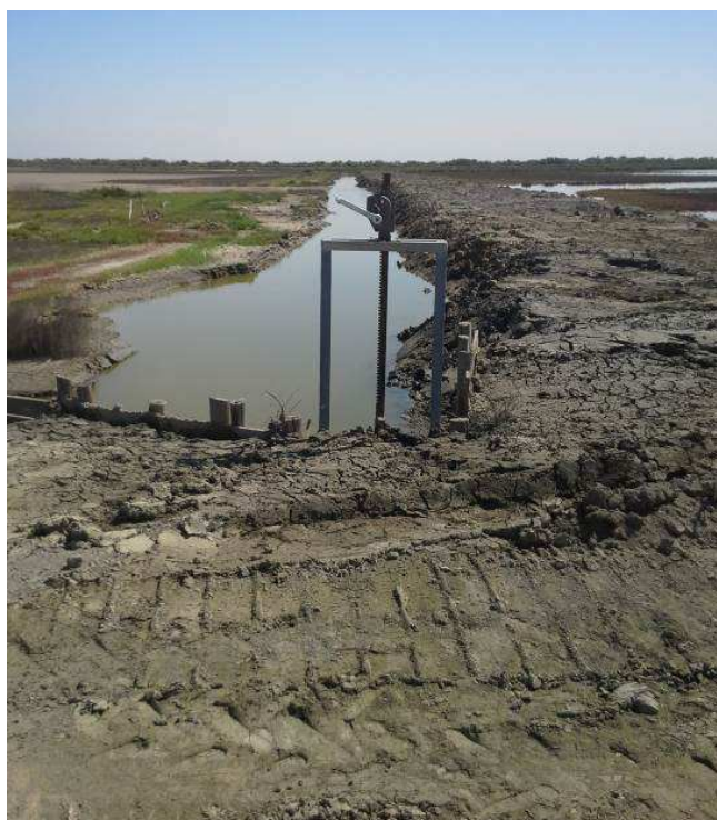
Pose de la martelière du Pèbre qui participe à la reconnexion du Fangassier avec son sous-bassin versant.
