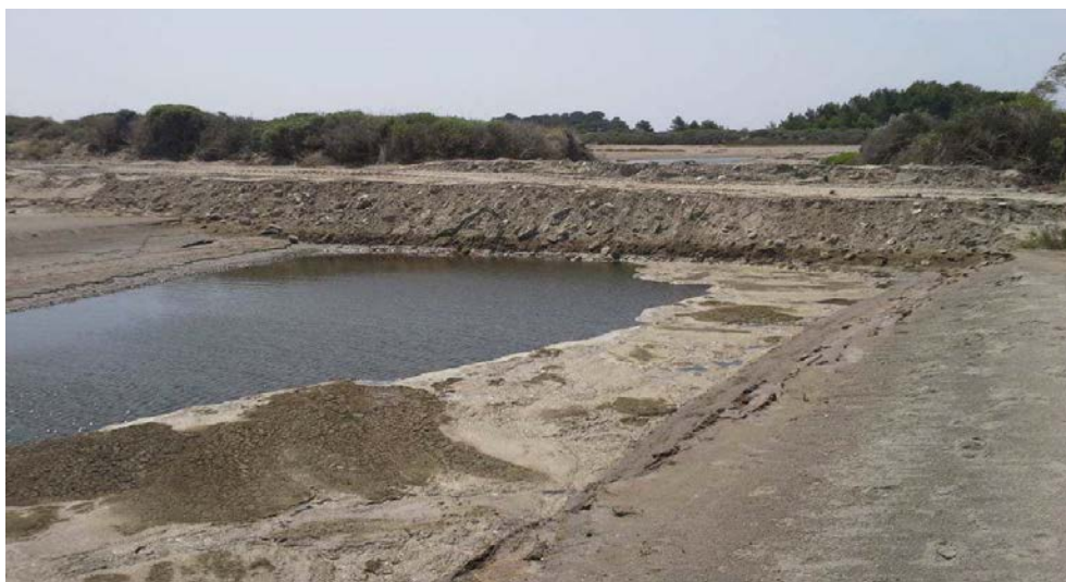
En haut : Brèche sur la digue de séparation entre Val Agricola et Pourtour Rascaillan 2 avant travaux. En bas : Digue réparée après travaux.
