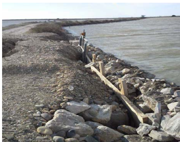
A gauche : Etat de l'ouvrage Tampan-Galabert (côté Galabert) avant démarrage des travaux de reprise de digue. A droite : Pose des bastaings, remblaiement en arrière et avec le tout venant et mise en place d'enrochements pour l'anti-batillage.
