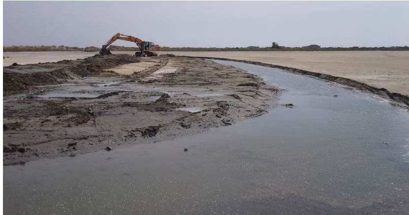
Curage du chenal entre Galabert 2 et l'ouvrage Galabert-Pourtour Rascaillan en juin 2015 (photo : PNRC).
