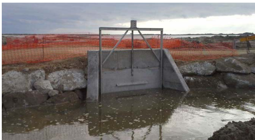
Ouvrage achevé en janvier 2016 (photo : PNRC).
