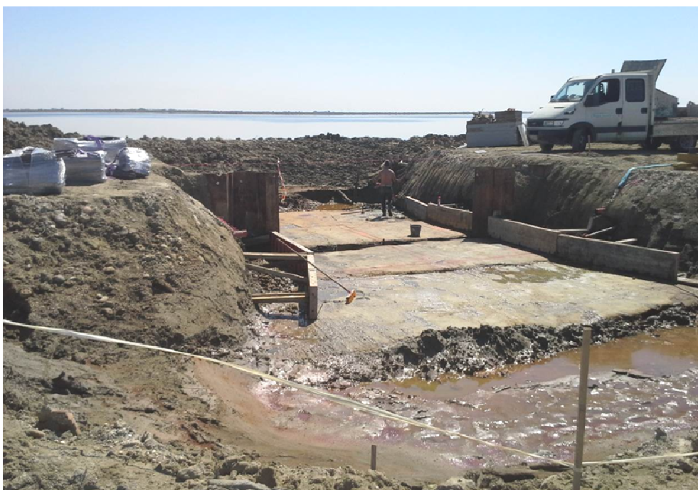
Coulage du radier en juin 2015 (photo : Parc de Camargue ).
