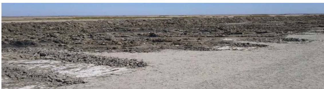
Reprises des berges de la digue du Rascaillan effectuées durant l'été 2015 par la Compagnie des salins sans l'autorisation du Conservatoire .
