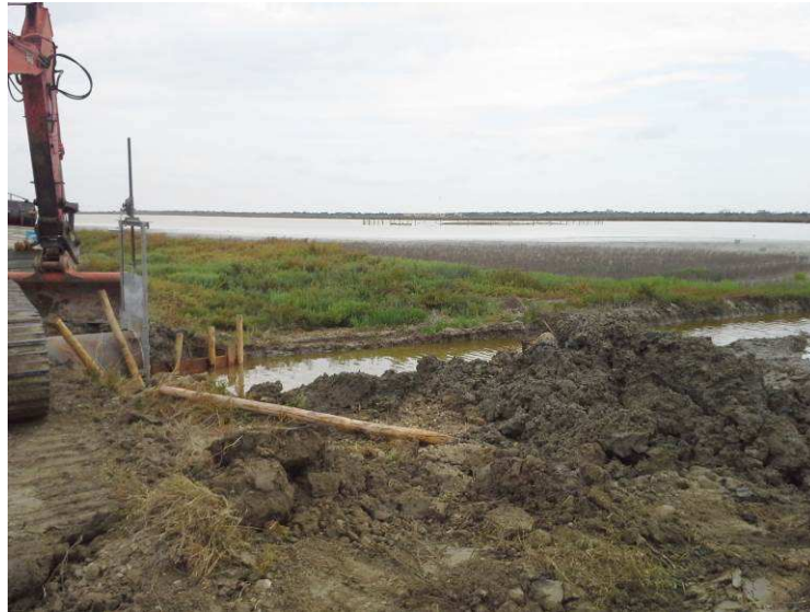
Pose de la martelière de vidange de l'ancien salin de la Vignole vers le Fangassier.
