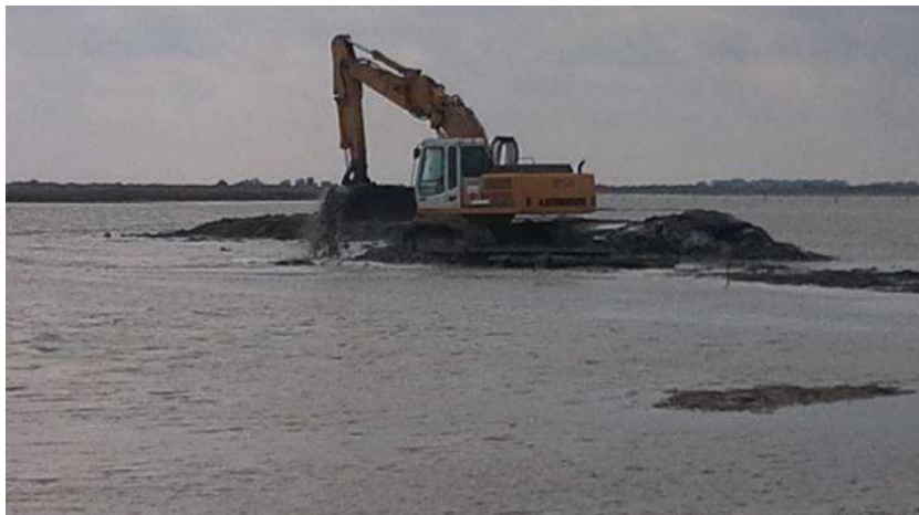
Curage du chenal dans le Pourtour du Rascaillan (décembre 2015) (photo : PNRC).
