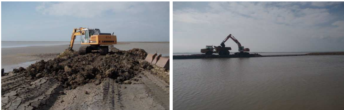
Travaux de coupure (à gauche) et d'effacement (à droite) de la digue centrale.
