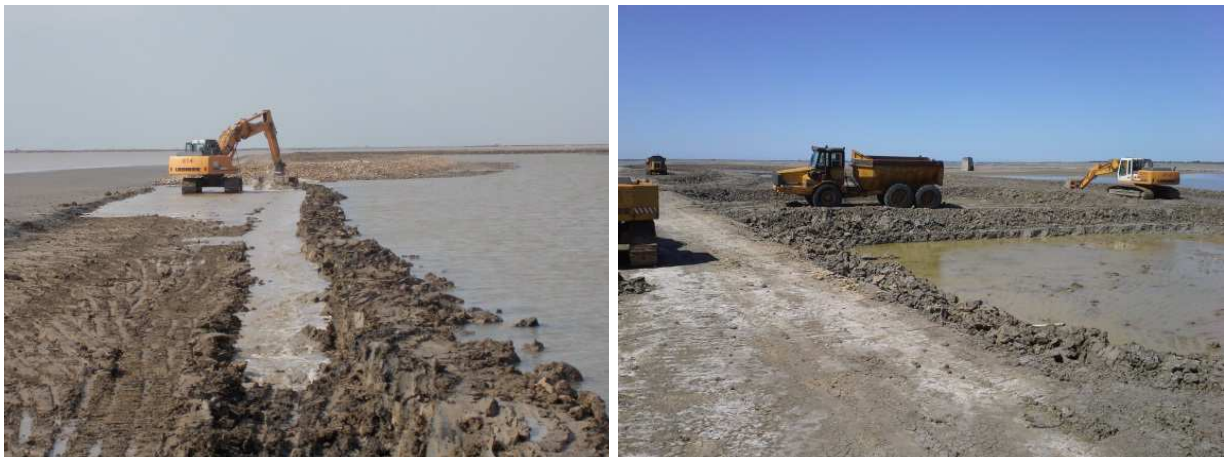
Le dernier coup de pelle autour de l'îlot (à gauche) et travaux de curage autour de l'îlot (à droite).
