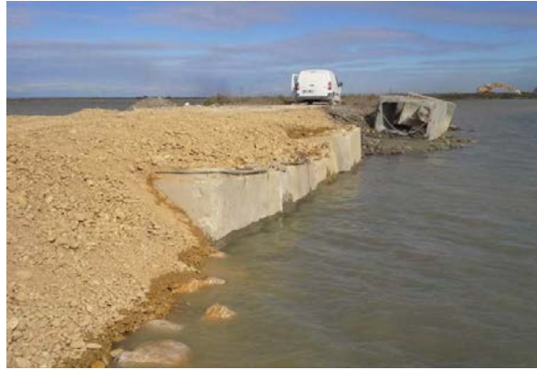
Coté Galabert, les dalots sont mis en place et comblés. Coté Tampan, l'anti-batillage est posé (mars 2015).
